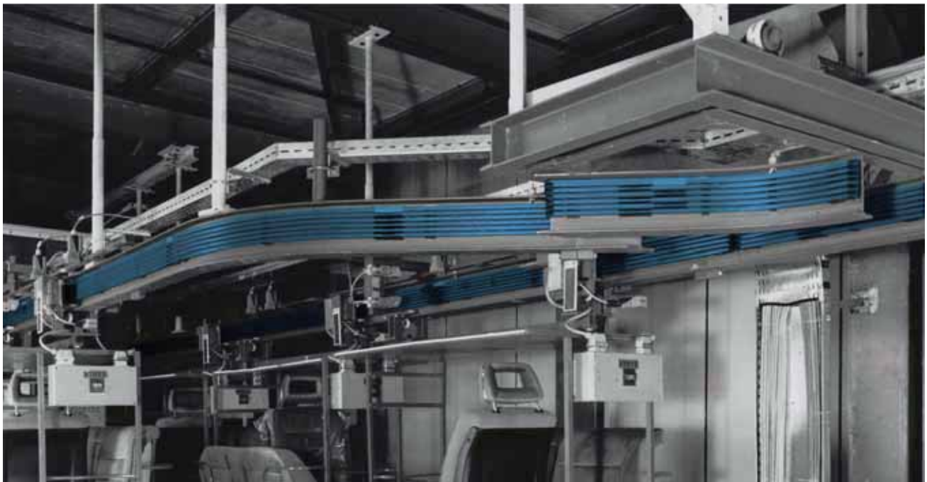
Rails conducteurs U 15 – 6 pôles alimentant un convoyeur avec aiguillage dans une usine automobile
